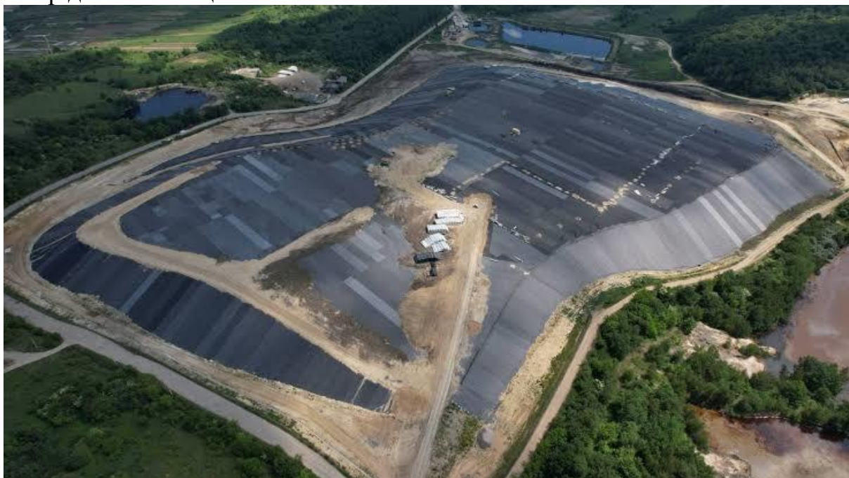
Рис. 2.9. Грибовицьке звалище в процесі рекультивации
