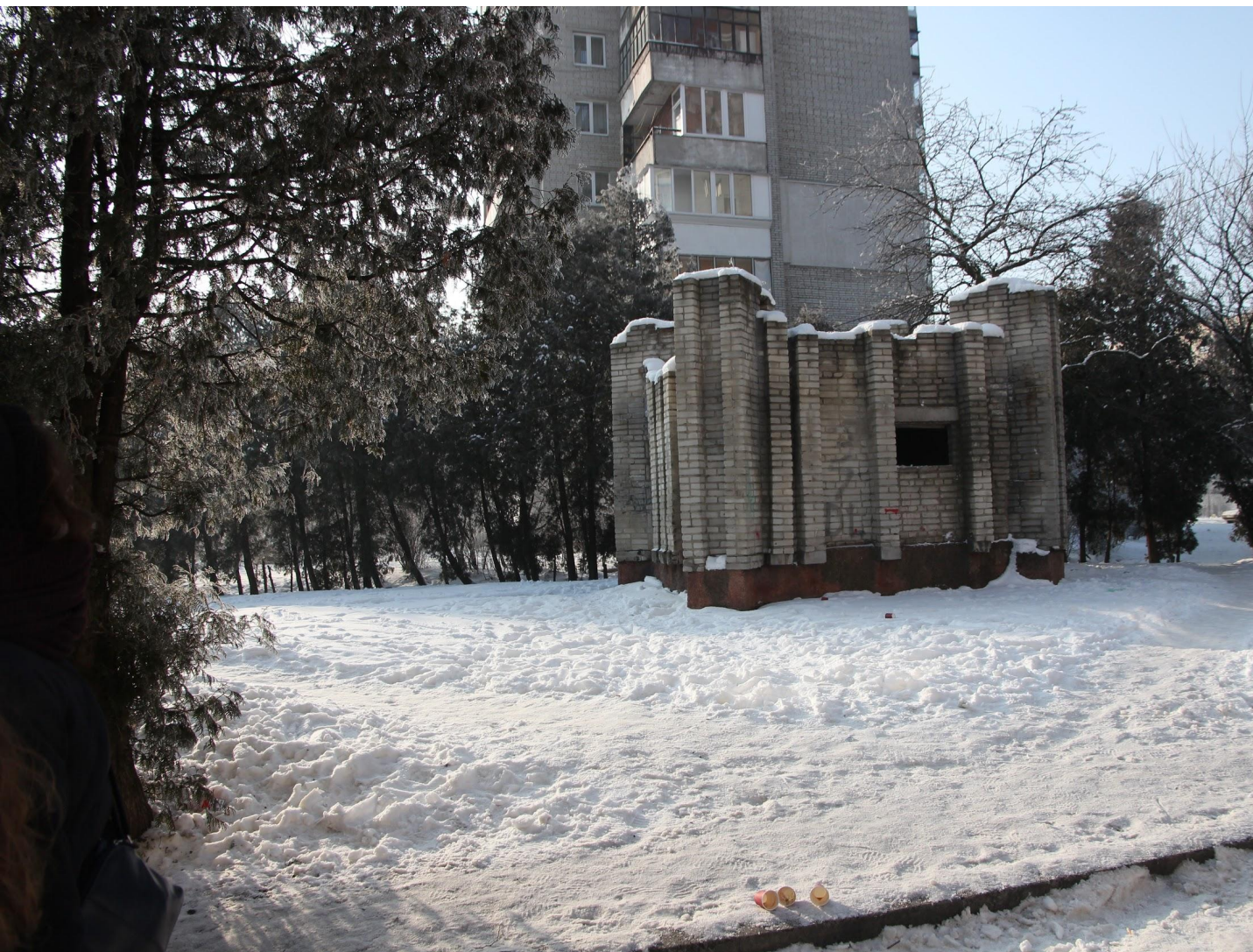
ЗРУЙНОВАНІ ІНЖЕНЕРНІ СПОРУДИ
