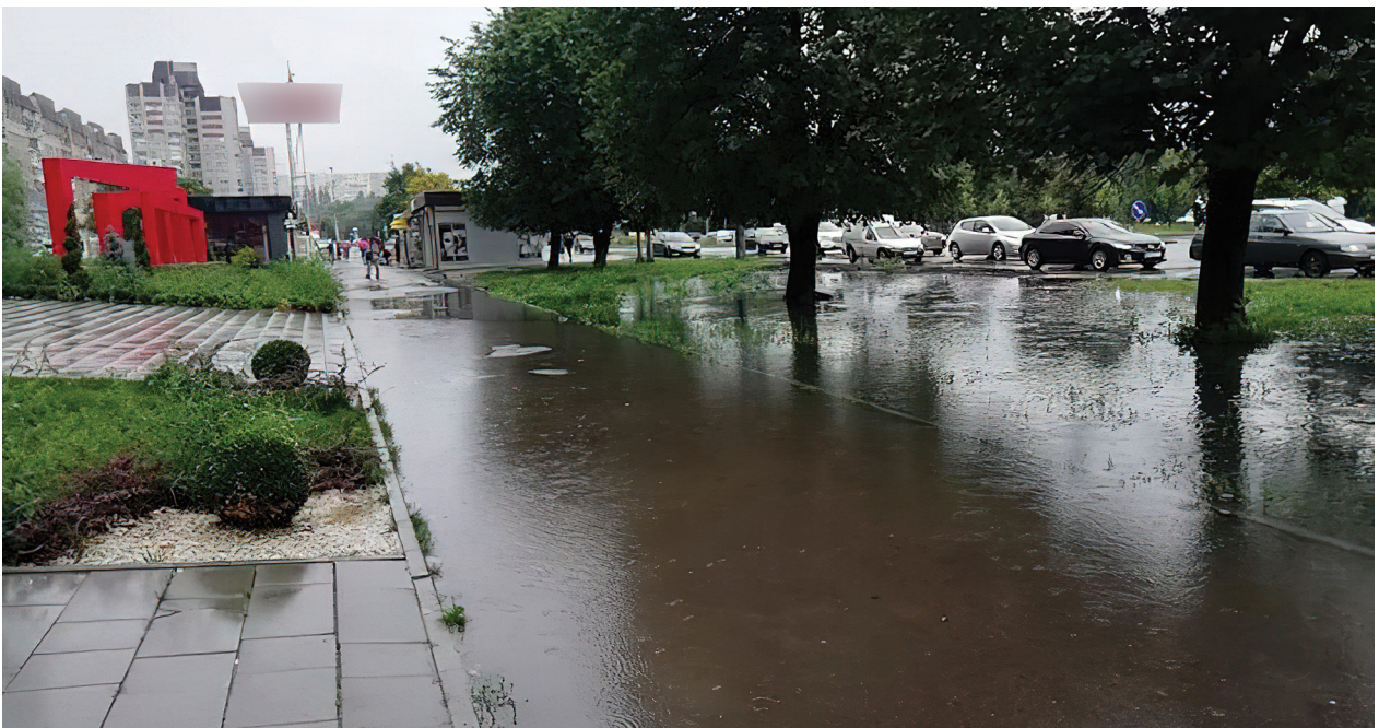
Рисунок 46. Підтоплення на пр. В. Чорновола у м. Львові
