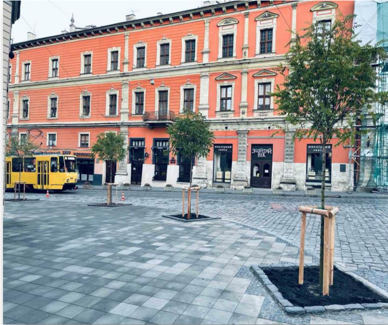
Поточний ремонт пл. Катедральної у 2022р.
