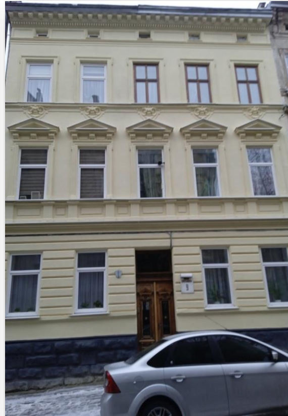
Ремонт фасаду На вул. Драгоманова, 9
