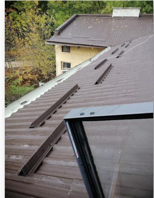
Ремонт покрівлі На вул. Зарицьких, 7
