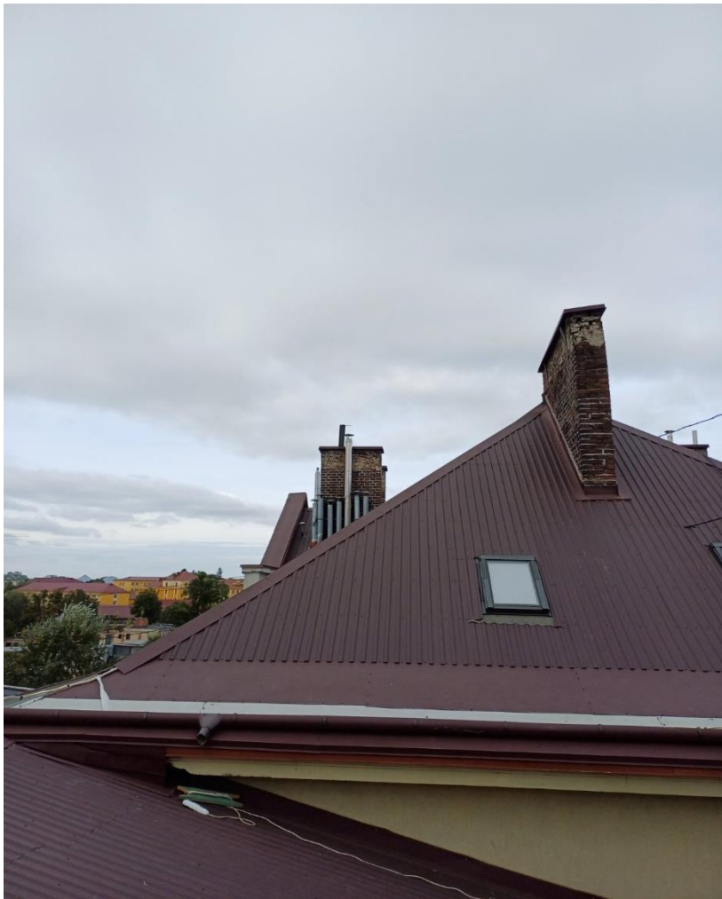
Замінено покрівлю пл.- 320 кв м
