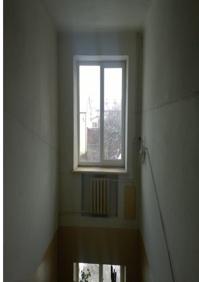
вул. Калнишевського, 8 (заміна вікна)
