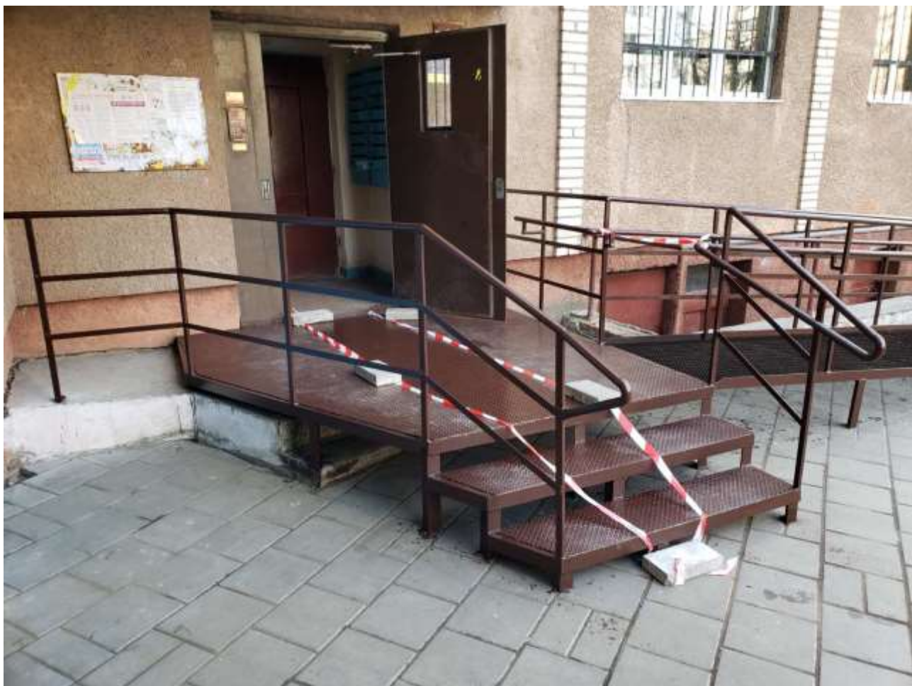
вул. Широка, 100 (зовнішній пандус)
