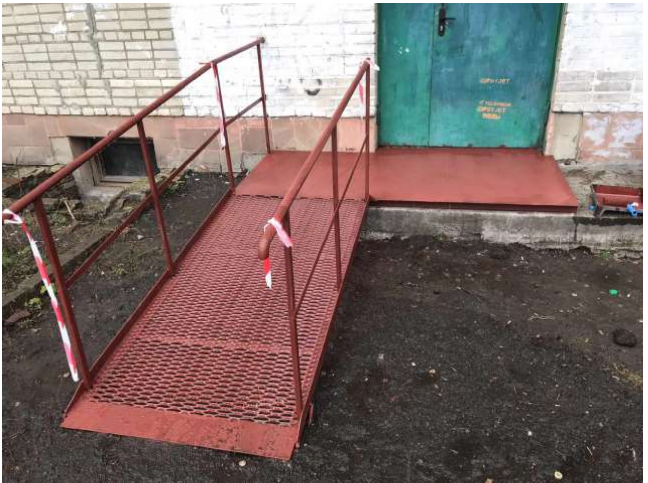
вул. Широка, 84 (зовнішній пандус)
