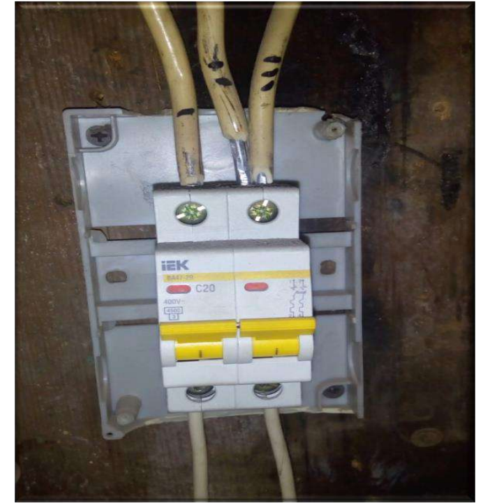
Вул. Під Дубом, 2 (заміна електрощитка)
