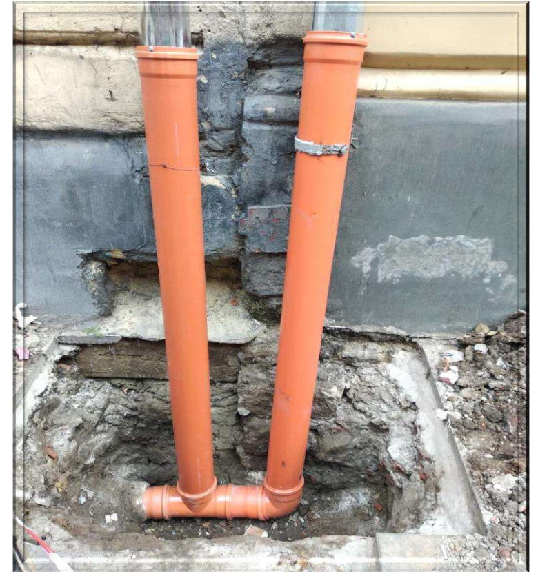
Вул. Шолом Алейхема, 8 (влаштування водовідводу)
