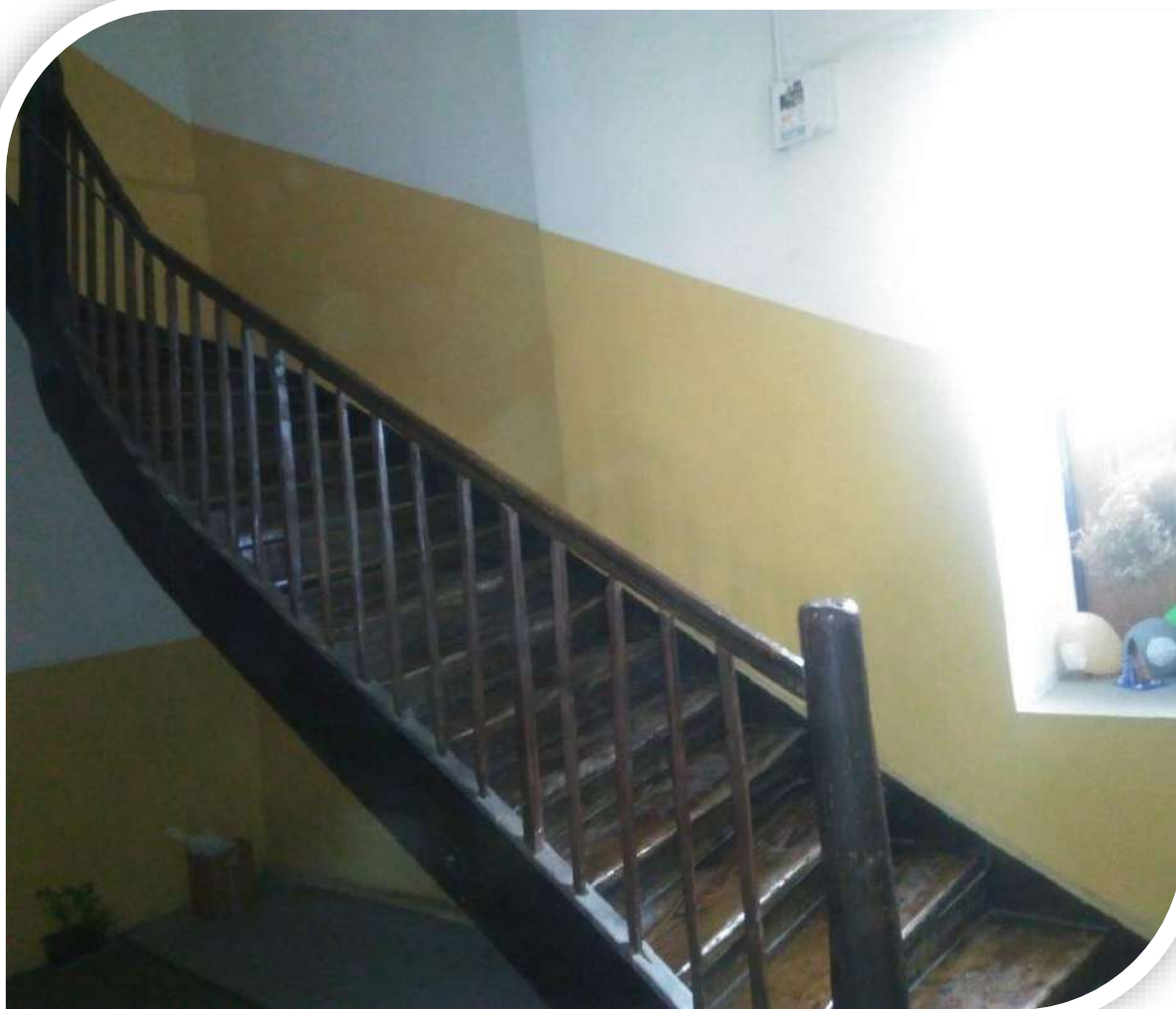
Вул. Стефаника, 11 (ремонт сходової клітки)
