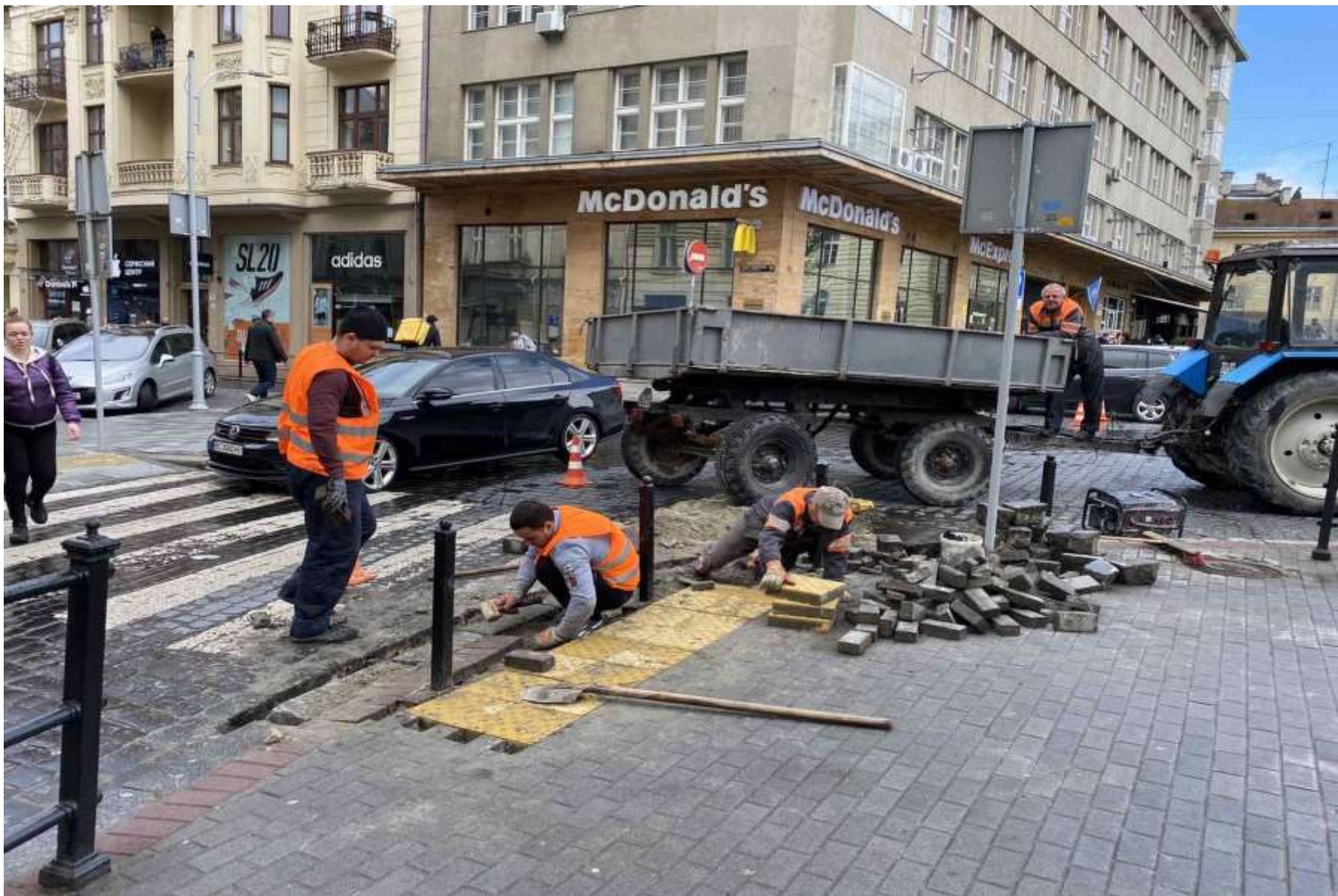
Влаштування пониження та тактильної плитки на пішохідних переходах для маломобільних груп населення
