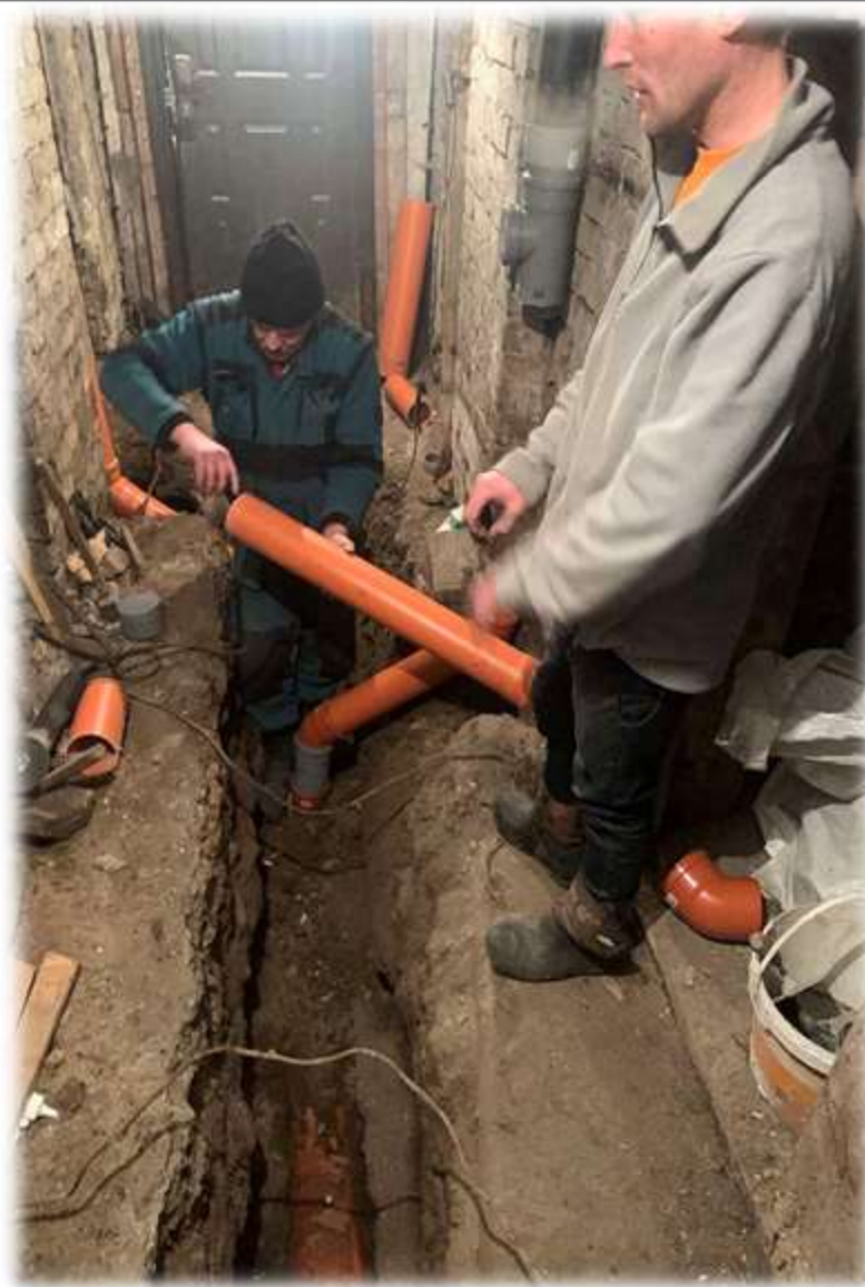
Пл. Старий Ринок, 2 (ремонт та заміна каналізаційної мережі)
