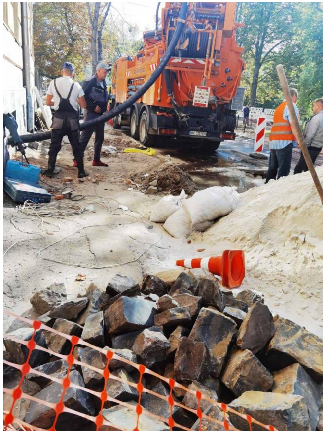
Заміна каналізаційного випуску, вул. Хімічна, 18
