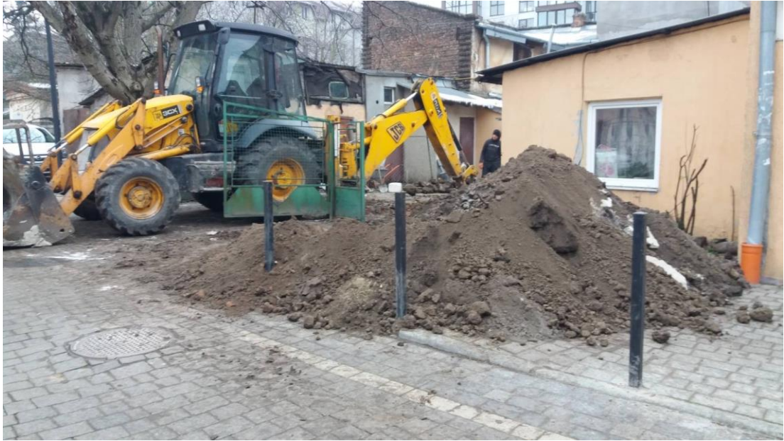
Заміна каналізаційного випуску, вул. Підрічна, 3
