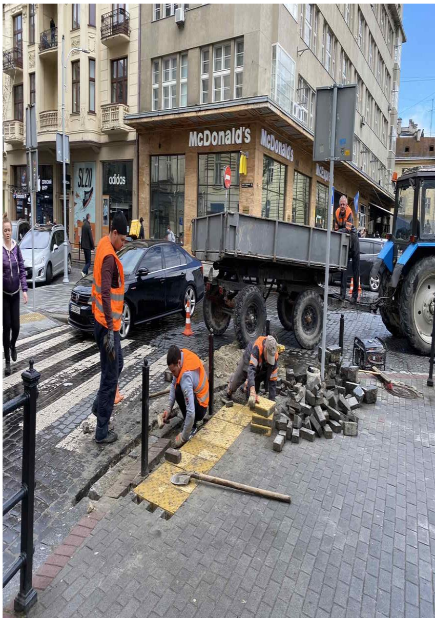
Влаштування пониження та тактильної плитки на пішохідних переходах для маломобільних груп населення
