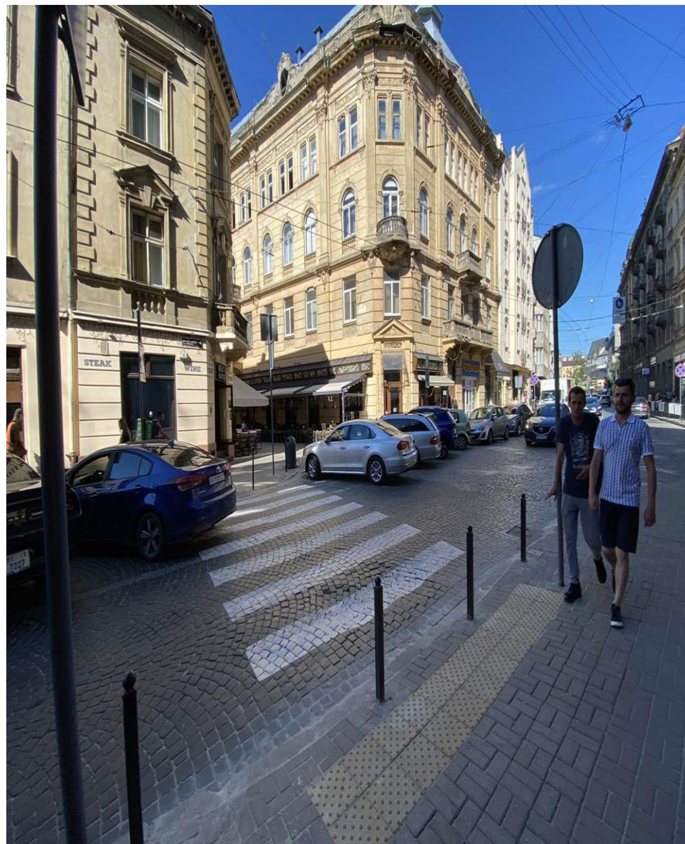
Влаштування пониження та тактильної плитки на пішохідних переходах для маломобільних груп населення
