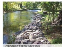
Укріплення берега каменями
