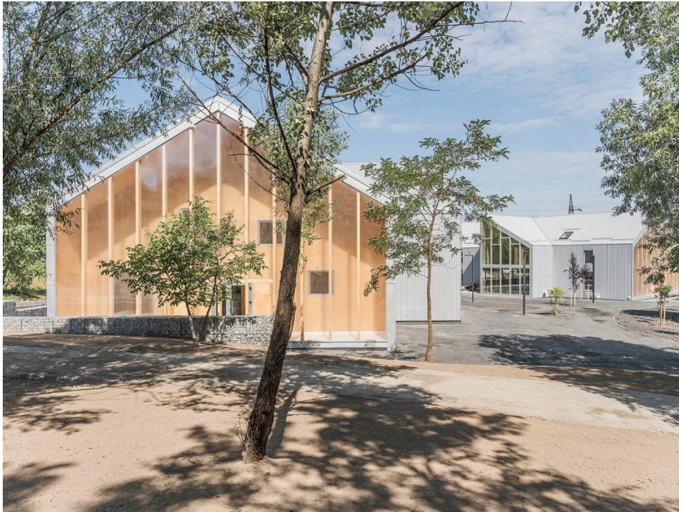
будинки створено за проєктом архітектурного бюро Sulykarchitects
