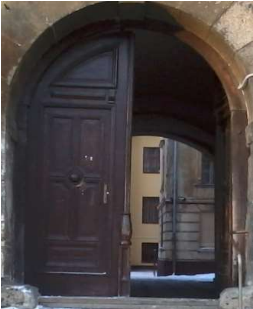
Вхід до будинку вул..Підвальна, 9 здійснюється з площі перед ним, через двостулчасту браму
