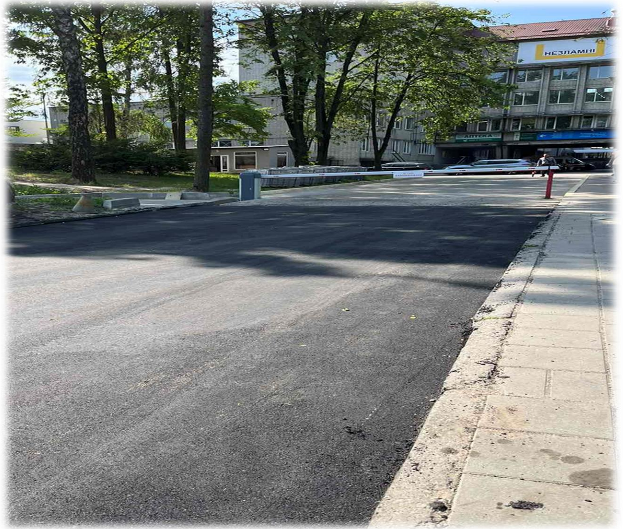
Поточний ремонт дороги на вул. Раковського
