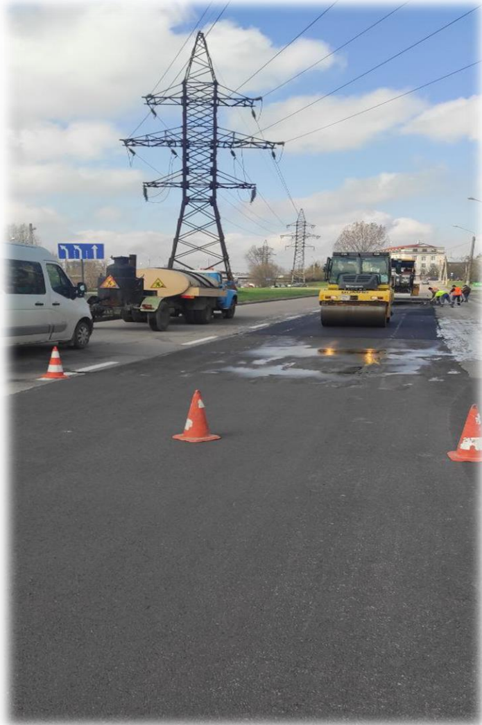
Поточний ремонт дороги на вул. Луганській
