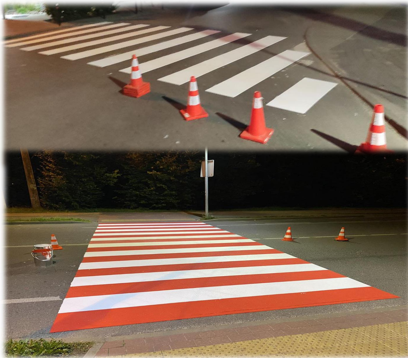
Нанесення поперечної дорожньої розмітки
