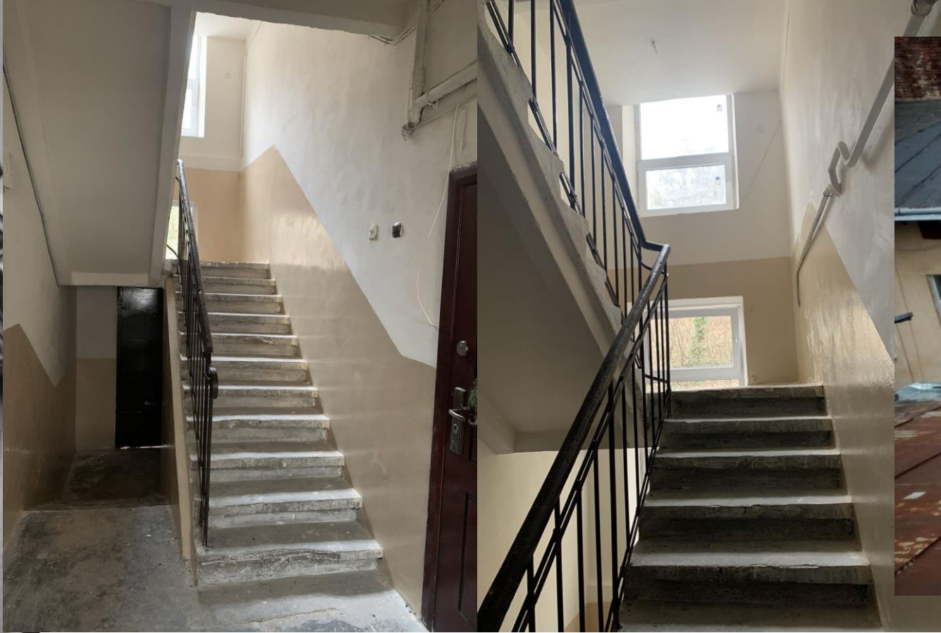
Вул. Кривоноса, 5 ремонт сходової клітки
