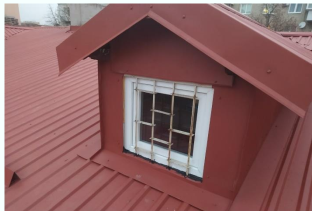
вул. Бр. Дужих, 3
