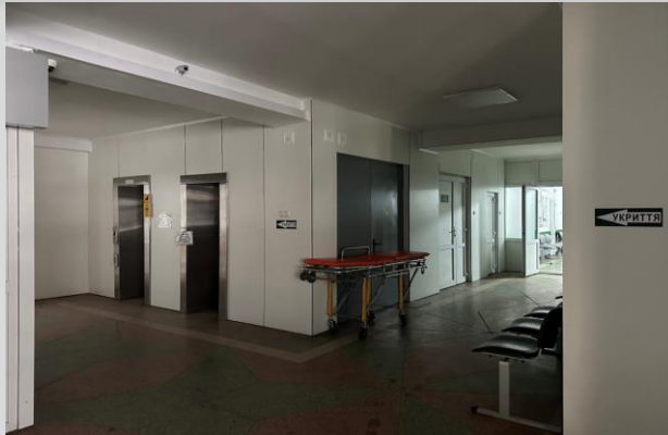
Поточний ремонт приміщень КНП « 3 МП м. Львова»
