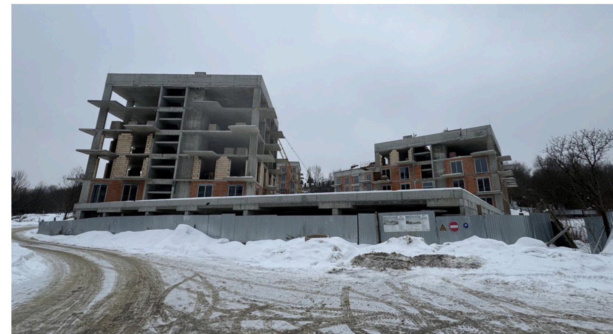
Триває будівництво решти будинків
