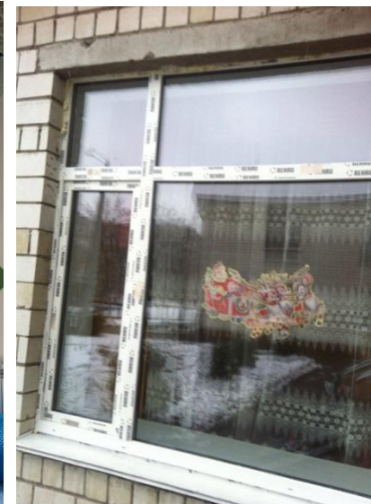
Капітальний ремонт із заміною вікон ЗДО "Веселка" на вул. Китайська, 6А
