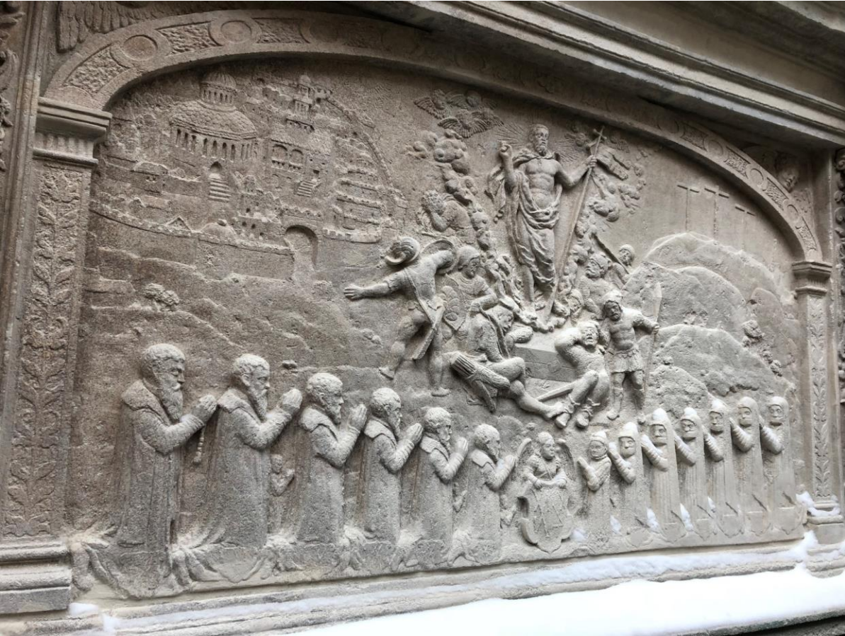
Реставрація рельєфу на фасаді Латинської Катедрі
