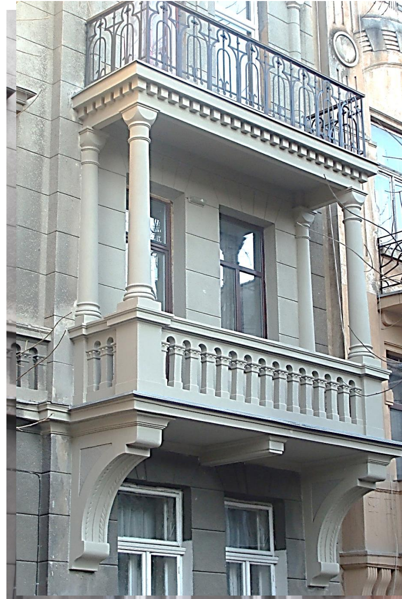
Ремонтно-реставраційні роботи балконів головного фасаду будинку на вул. Д. Менделєєва, 9
