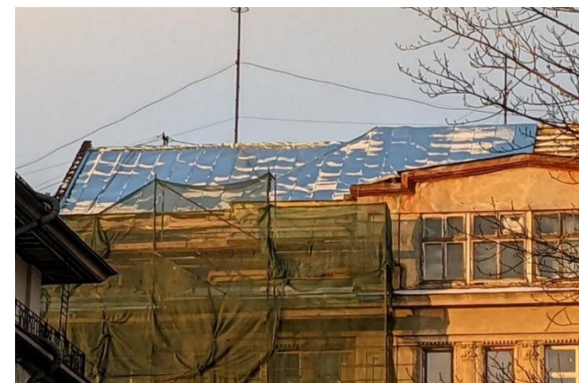
Реставраційно-ремонтні роботи будинку-пам'ятки архітектури на вул. Б. Хмельницького, 11
