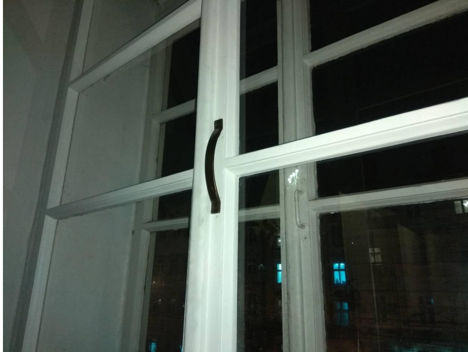
Ремонтно-реставраційні роботи вікон Ратуші на пл. Ринок, 1
