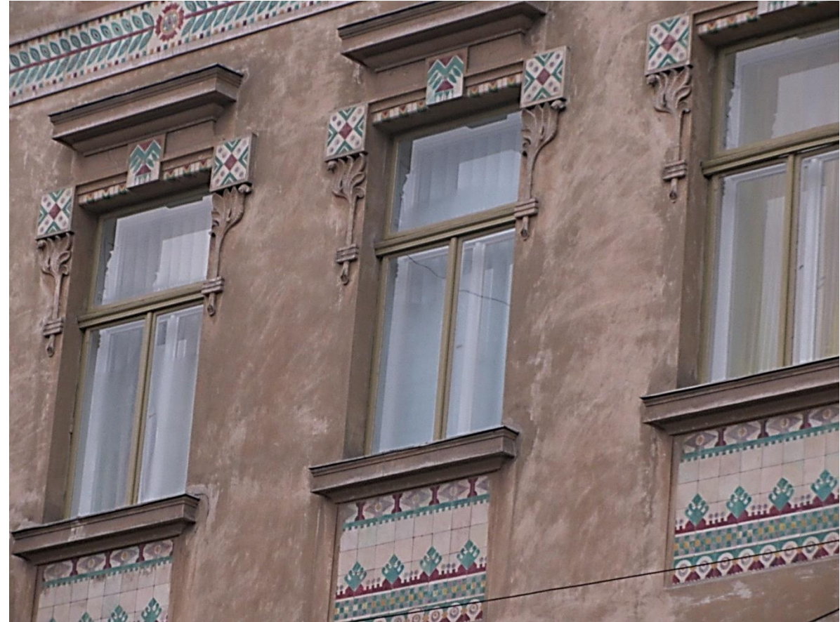
Реставраційно-ремонтні роботи пам'ятки архітектури ХХ ст. (охоронний № 391) будинку страхового товариства "Дністер" на вул. Руській, 20 (1-а міська поліклініка). Реставрація вікон.
