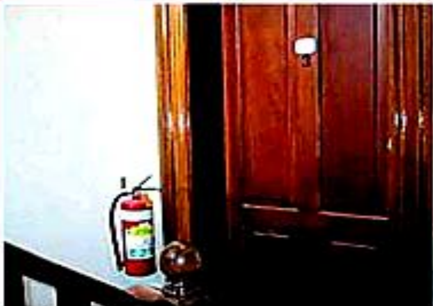
Рисунок 7. Приклад навішування вогнегасника
